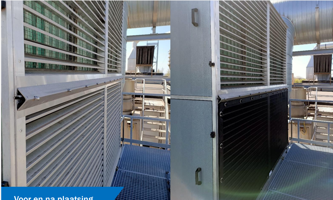
Voor en na plaatsing
