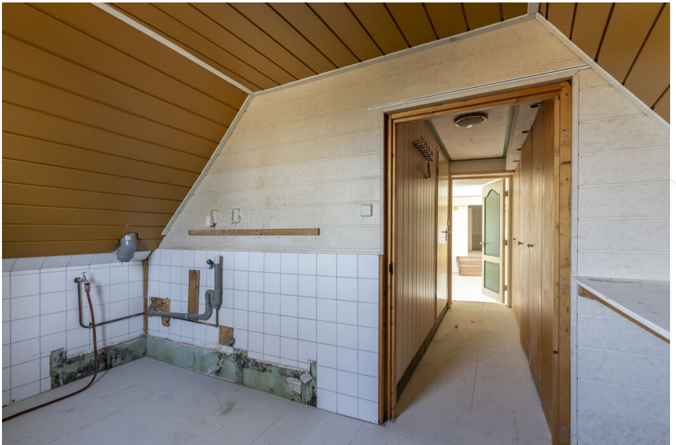
Bijkeuken / Technische ruimte
