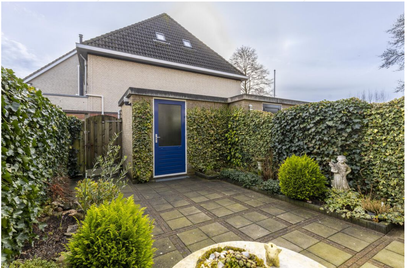
Stenen berging en achterom
