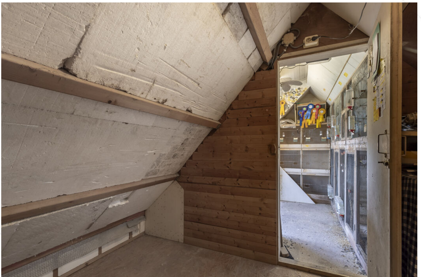
Verdieping stenen berging
