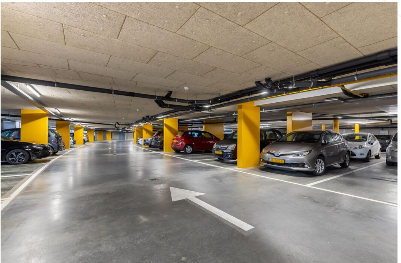
Parkeerkelder met eigen parkeerplaats
