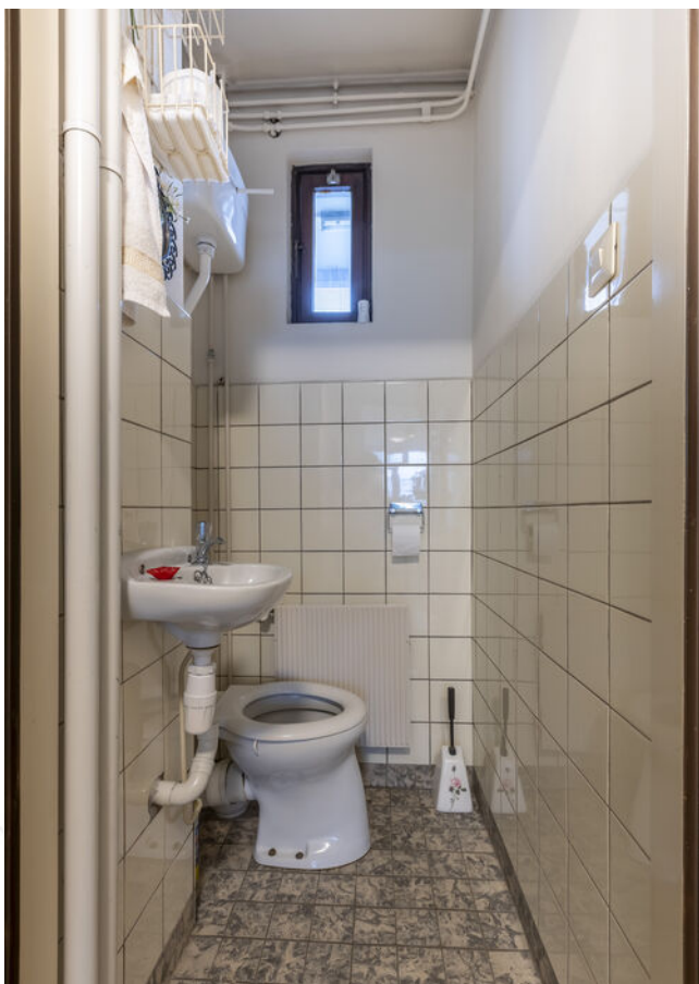
Toilet 1e verdieping
