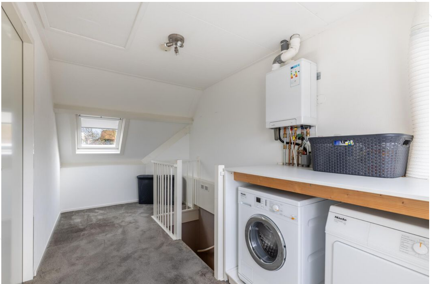
Overloop 2e verdieping
