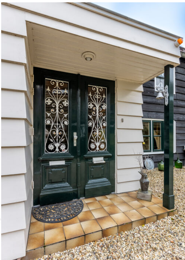
(Dubbele) voordeur woning
