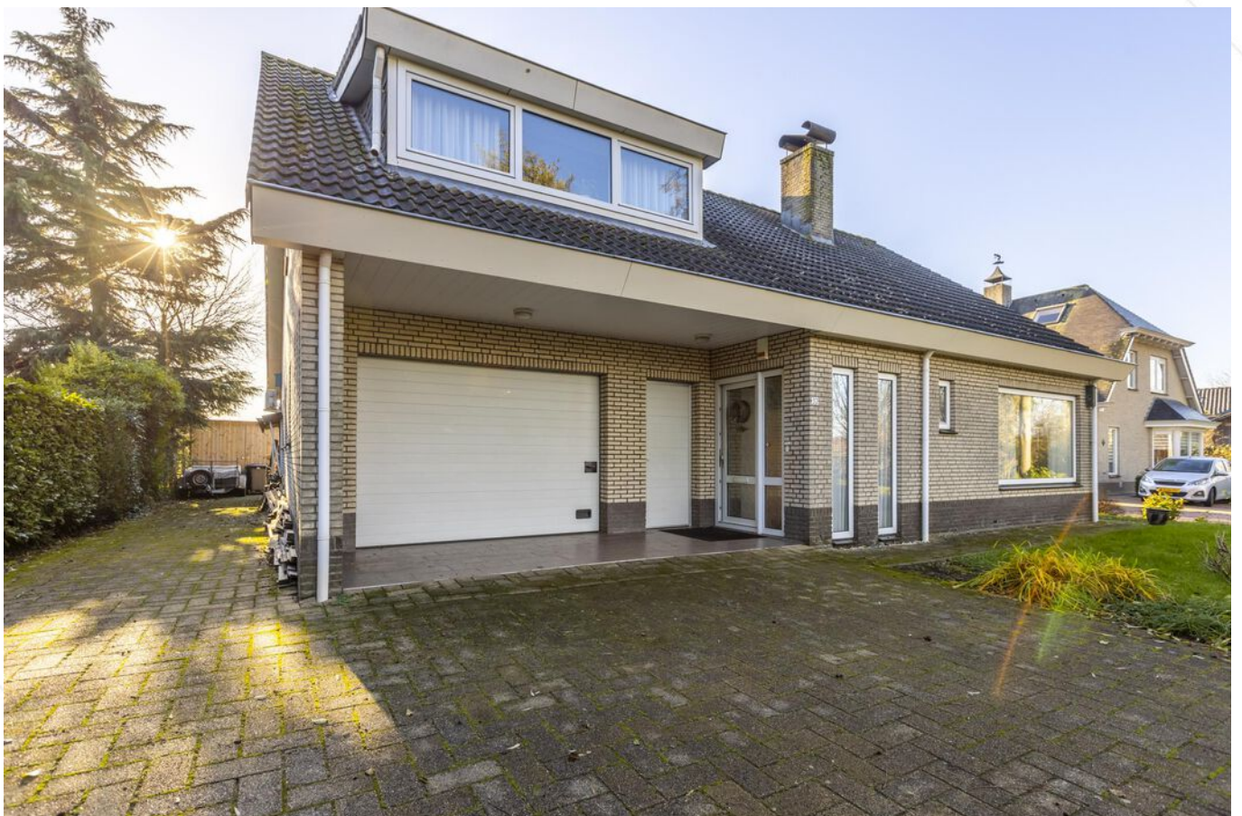
Oprit en toegang tot (boten/camper) berging
