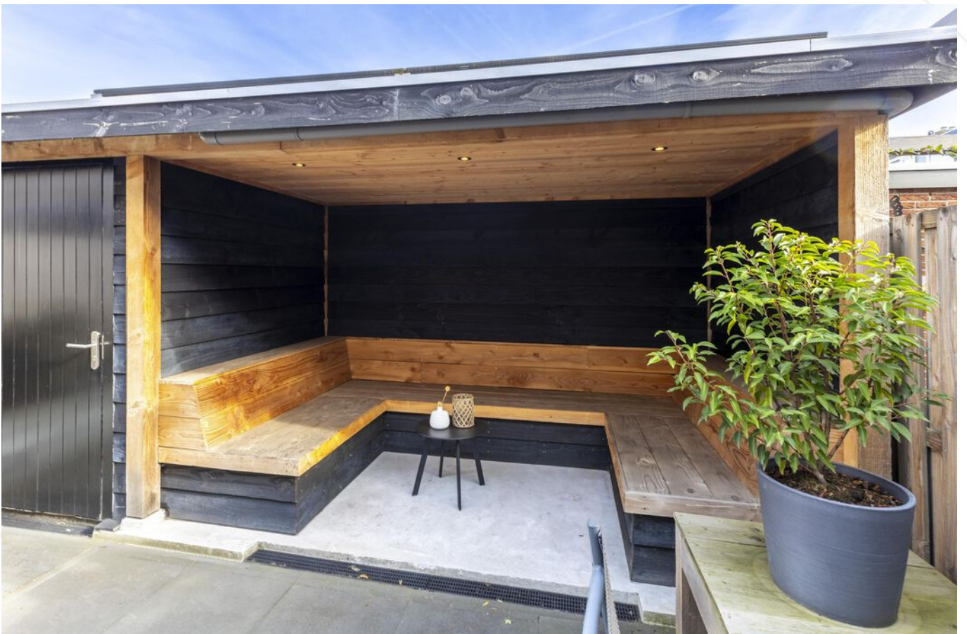
Berging met loungehoek en zonnepanelen
