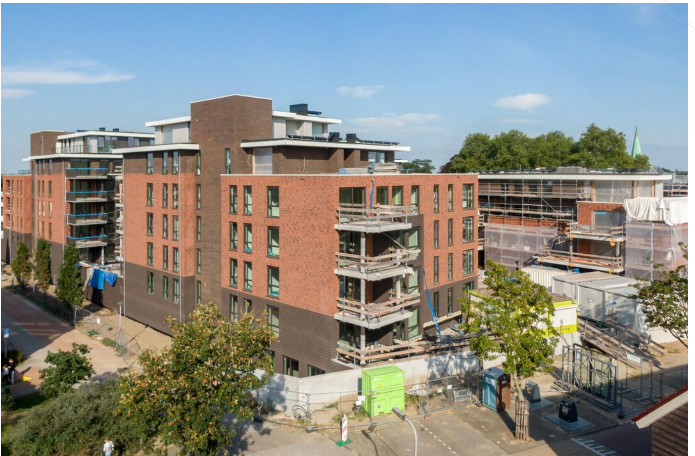
Aanzicht complex vanuit het zuid-westen
