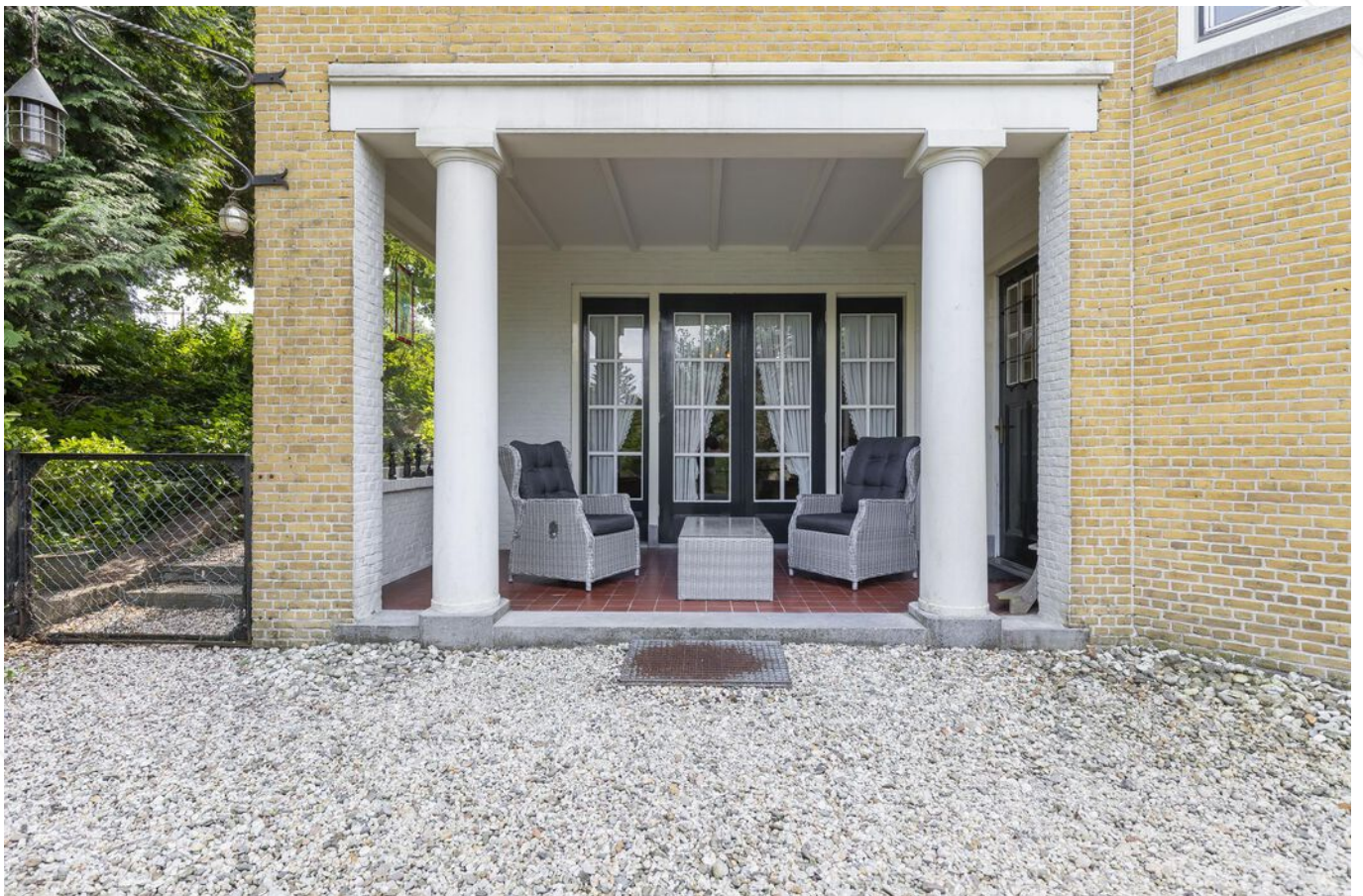
Overdekt terras/loggia met ronde draagkolommen met architraaf
