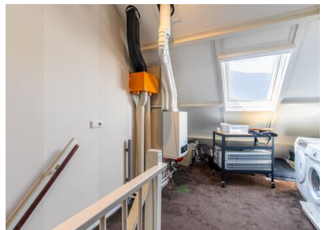
Overloop 2e verdieping
