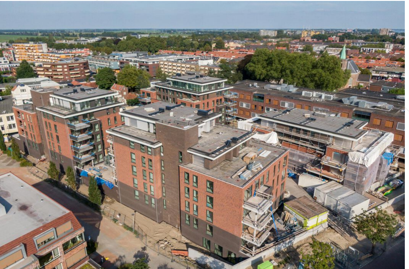
Overzicht complex (vanuit zuid-westen)
