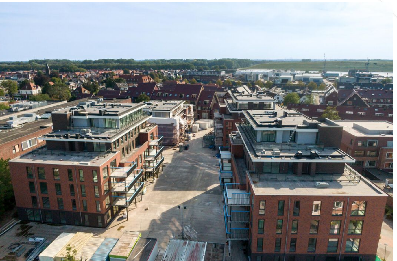
Overzicht complex (vanuit noorden)
